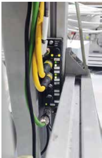
Kompaktné rozhranie RFID TBEN-S2 od spoločnosti Turck zaisťuje rýchly a spoľahlivý prenos údajov.
